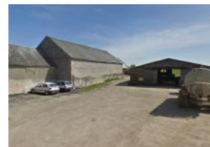
Le bâti agricole ancien
